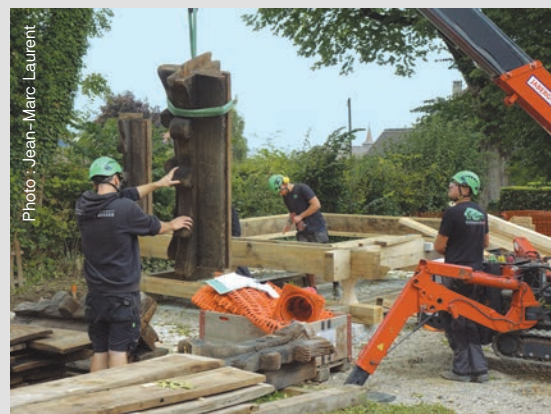
Fig. 3. Le grenier en cours de remontage à Fey par les collaborateurs de Treg Sàrl, 2025.
