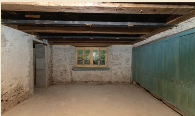
Appartement du rez, «chambre bleue» ou chambre à coucher, avant travaux.
