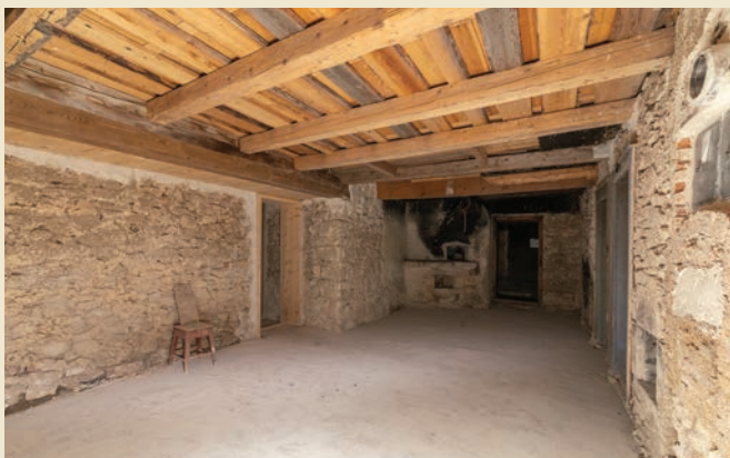
Appartement du rez, cuisine, et son ancien four à pain (au fond), avant travaux.
