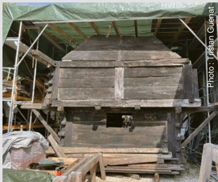
Fig. 2. Le grenier mis à l'abri près de l'atelier de Tristan Guenat (Treg Sàrl), 2023.
