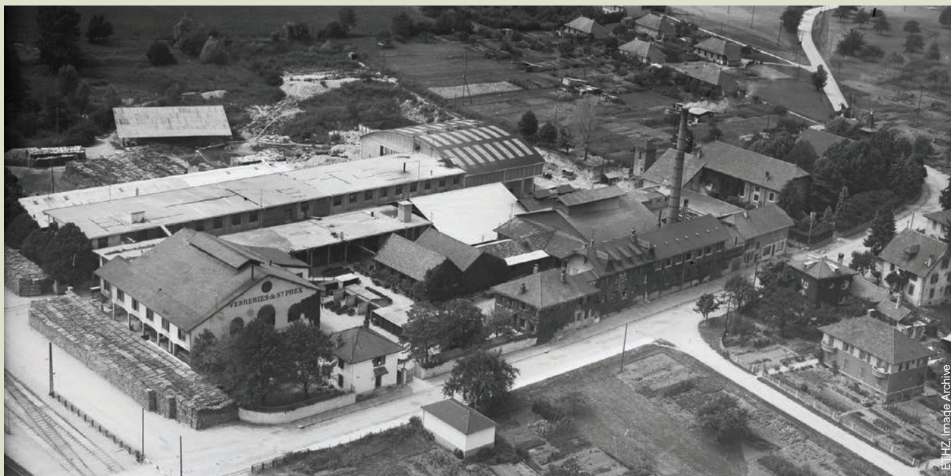
Fig. 6. Le site de la verrerie en 1946. La nouvelle halle des fours au nord-est de l'entrepôt en béton armé construit en 1921 (surélevé en 1928 et 1938) en remplacement d'un hangar en bois détruit par un incendie. Au fond, la carrière de sable. Photo Werner Friedli, 15 août 1946 (ETH Library Zurich, LBS_H1-009496).
