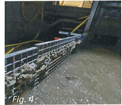
Fig. 2-4, images du canal d'entrée des eaux avant, pendant et après un épisode de pluie abondante. La présence des déchets solides est importante, elle bouche la grille située en bordure du canal. Si elle n'est pas nettoyée rapidement et de manière fréquente, elle devient inefficace. Les déchets supplémentaires ne sont plus filtrés et se déversent de manière massive directement dans le lac. Cette grille n'est donc pas suffisante à retenir la quantité des déchets arrivant dans la STEPi.
