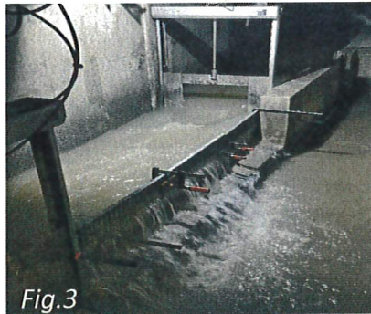
Fig. 2-4, images du canal d'entrée des eaux avant, pendant et après un épisode de pluie abondante. La présence des déchets solides est importante, elle bouche la grille située en bordure du canal. Si elle n'est pas nettoyée rapidement et de manière fréquente, elle devient inefficace. Les déchets supplémentaires ne sont plus filtrés et se déversent de manière massive directement dans le lac. Cette grille n'est donc pas suffisante à retenir la quantité des déchets arrivant dans la STEPi.
